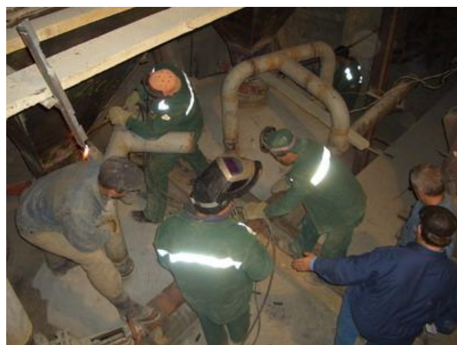
Рис.10. Шефмонтаж пневнокамерных насосов на ОАО Горнозаводскцемент.
