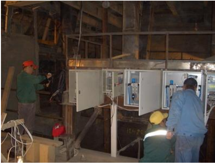
Рис.10. Шефмонтаж и наладка пневмошкафов и шкафов управления на ОАО Горнозаводскцемент.
