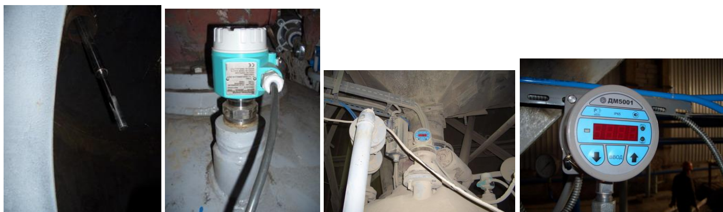
Рис.3. ПКН оснащены высоконадежными сенсорами – датчиками уровня и цифровым манометром с мембранным разделителем.
