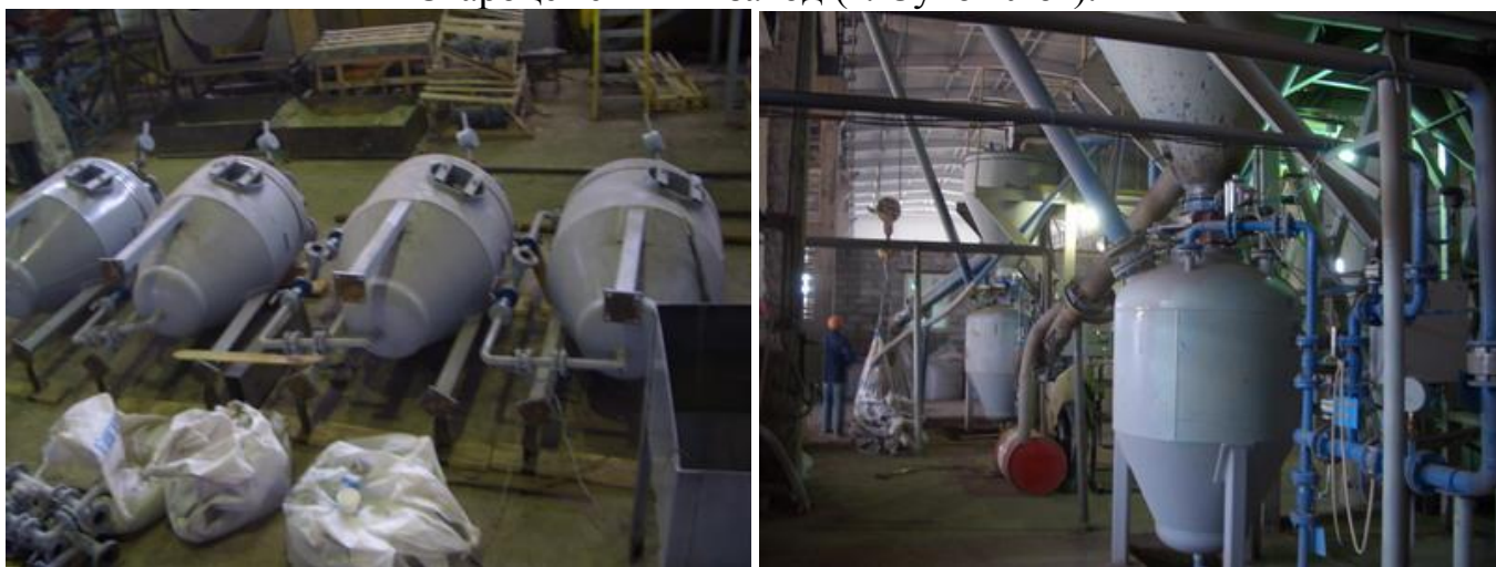
Рис.1. Поставка и монтаж ПКН на завод компании ФОРЭС г. Шадринск.
