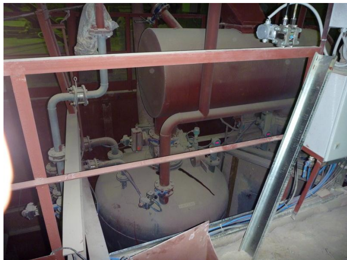
Рис.8. ПKN-6 м 3 производительностью 50 т/ч изготовленные для ООО Староцементный завод (г. Сухой Лог).
