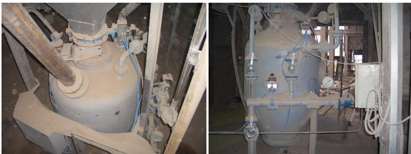
Рис.2. ПКН могут работать в тяжелых условиях повышенной запыленности. Все комплектующие имеют степень защиты IP-65.
