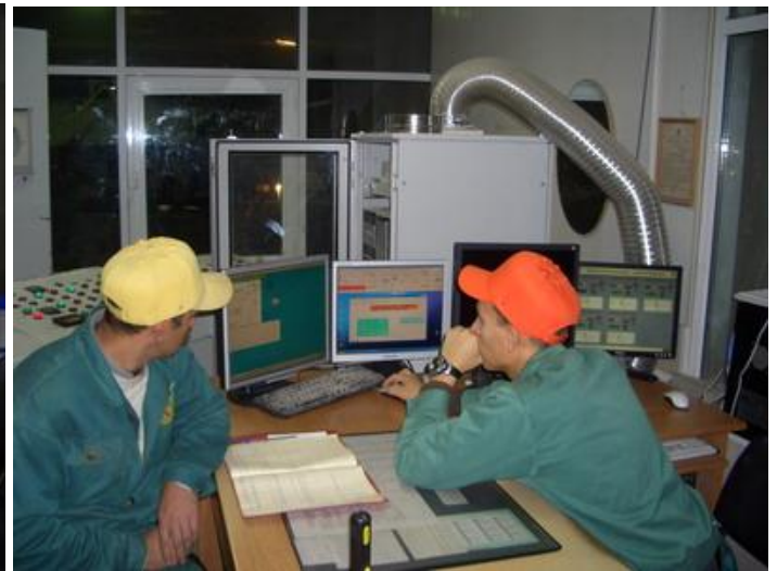
Рис.10. Наладка программного управления верхнего уровня на пультовой цеха «ПОМОЛ» ОАО Горнозаводскцемент
