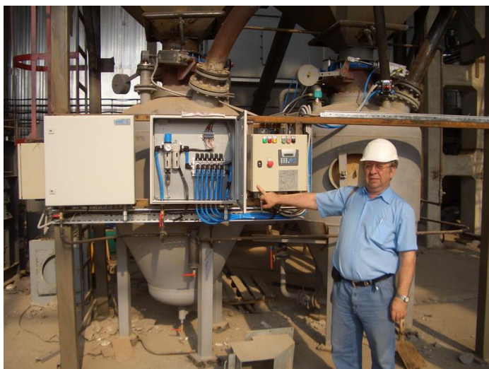
Рис.7. ПKN-1.5 м 3 производительностью 30 т/ч изготовленные для ООО ФОРЭС (г. Асбест).
