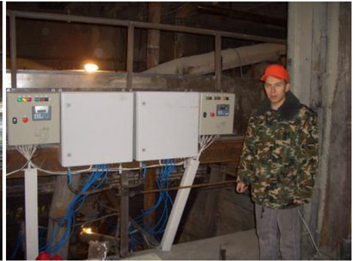
Рис.10. Шефмонтаж и наладка пневмошкафов и шкафов управления на ОАО Горнозаводскцемент.
